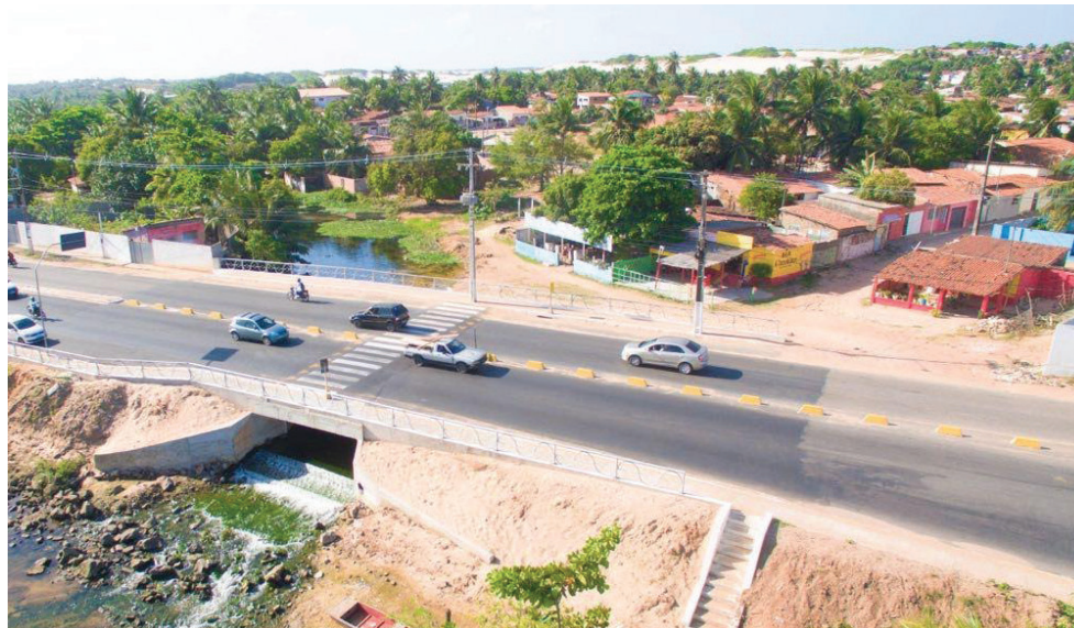
As obras foram realizadas num período 120 dias e custaram R$ 718 mil. A obra ampliou a capacidade de vazão da tubulação
